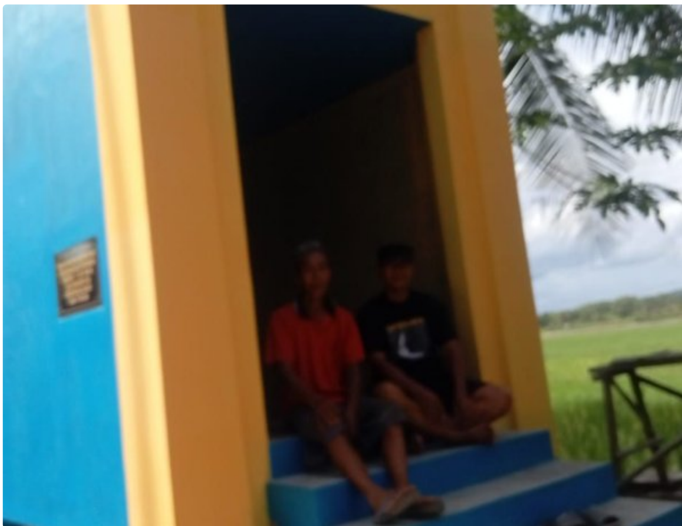
Pembangunan Irigasi Perpompaan di Desa Binangun
